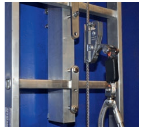
Vertikale Steigsicherung: die Alternative, falls keine Zwischenpodeste
